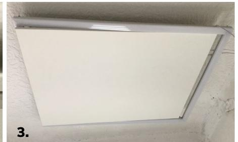
**4.** Hinteren, überstehenden Teil des LED Leuchtrahmens hochheben, bis die Metallaufgaben auf Höhe der IR-Paneloberseite sind. Dann überstehenden LED Leuchtrahmen Richtung Stirnseite des IR-Panels schieben, bis dieser ansteht.
