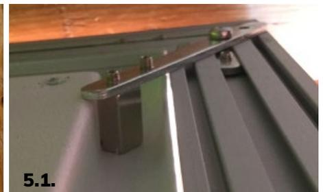
**5.** Alle Ecken des LED Leuchtrahmens liegen nun gleichmäßig am IR-Panel auf. (Bei ICONIC-Serie und Smartline kann der LED Leuchtrahmen wahlweise mit vier mitgelieferten Magneten von ca. 10 mm auf Überstand ca. 5 mm mit Infrarotpanelunterseite reduziert werden. Die Magneten werden dann jeweils unter den Eckauflagen des LED Rahmens platziert. Abb. 5.1.)
