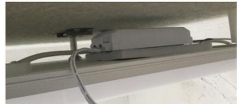
**1.** LED Leuchtrahmen am IR-Panel einhängen. **2.** Bis an weiße Abstandshalterung schieben. **3.** LED Leuchtrahmen hochschwenken.
